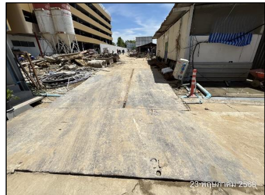
รูปที่ 21 แผ่นเหล็กปูบริเวณภายในพื้นที่โครงการที่รถวิ่งผ่าน
