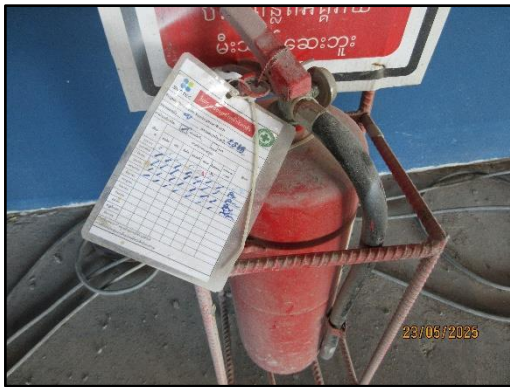
รูปที่ 67 การตรวจสอบสภาพของถังเคมีดับเพลิง
