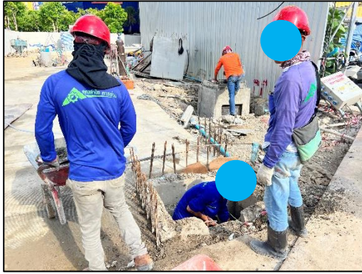
รูปที่ 39 ขุดลอกท่อระบายน้ำบริเวณด้านหน้าโครงการ
