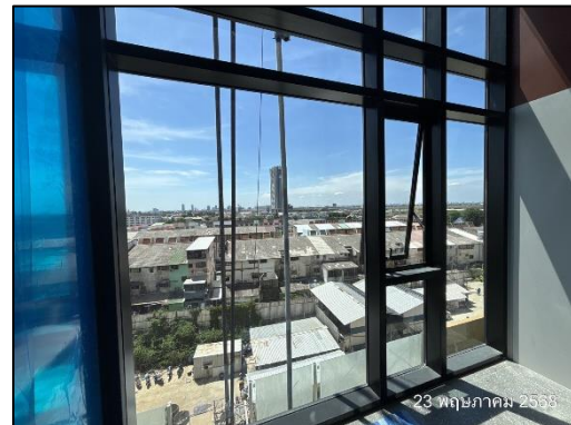
รูปที่ 98 ติดตั้งผนังอาคารและกระจกโดยรอบ
