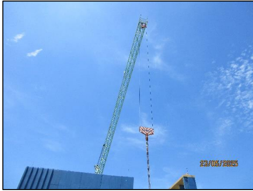
รูปที่ 57 การควบคุมแกนของเครนให้อยู่เฉพาะภายในพื้นที่โครงการ
