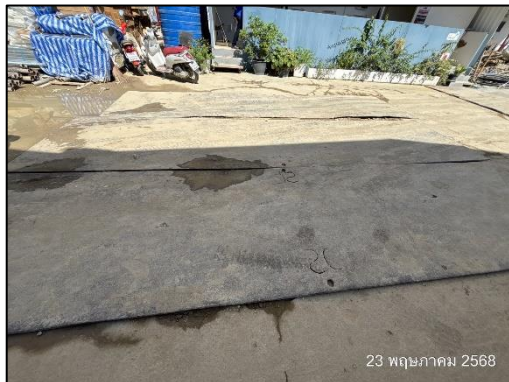
รูปที่ 21 แผ่นเหล็กปูบริเวณภายในพื้นที่โครงการที่รถวิ่งผ่าน
