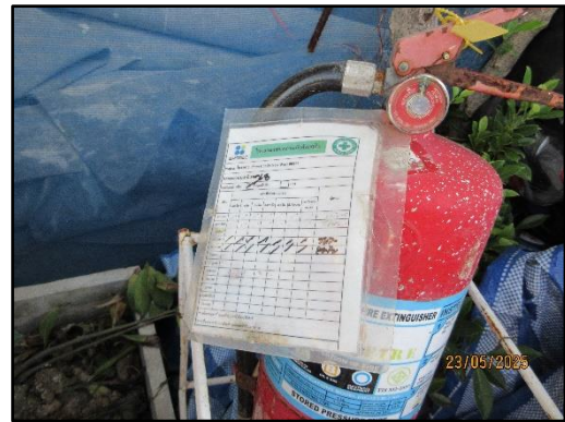
รูปที่ 67 การตรวจสอบสภาพของถังเคมีดับเพลิง
