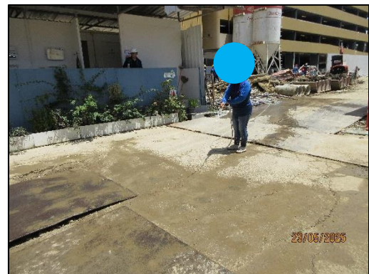
รูปที่ 9 การฉีดพรมน้ำบริเวณพื้นที่ก่อสร้าง
