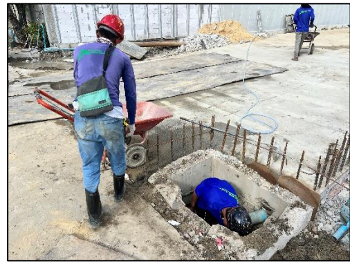
รูปที่ 39 ขุดลอกท่อระบายน้ำบริเวณด้านหน้าโครงการ
